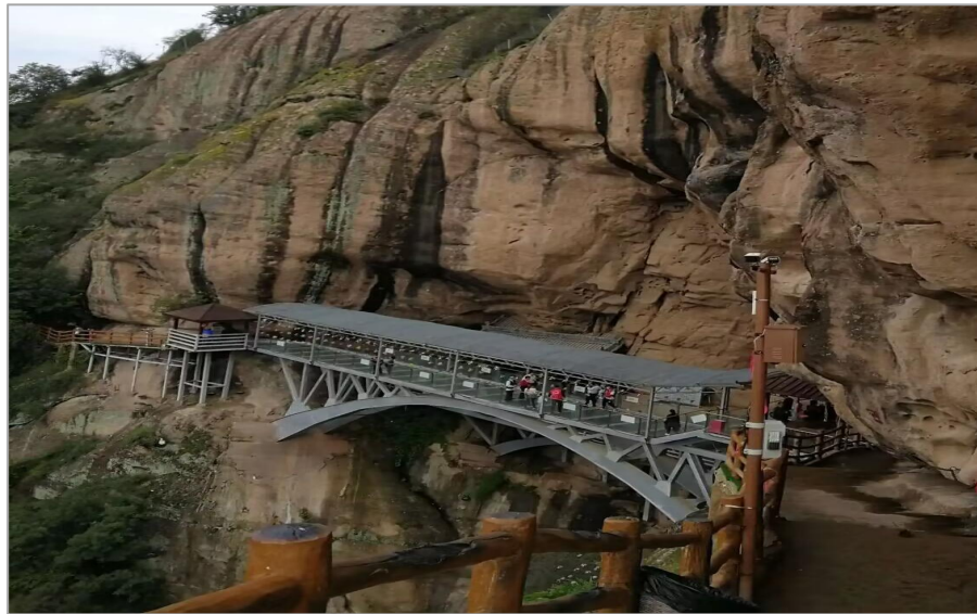
悬空观景玻璃廊道实景图
