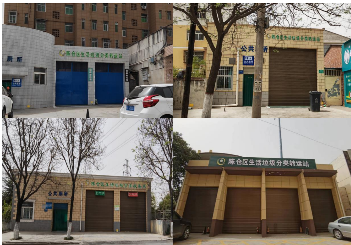
图 3-4-1 陈仓区城区垃圾转运站现状图
